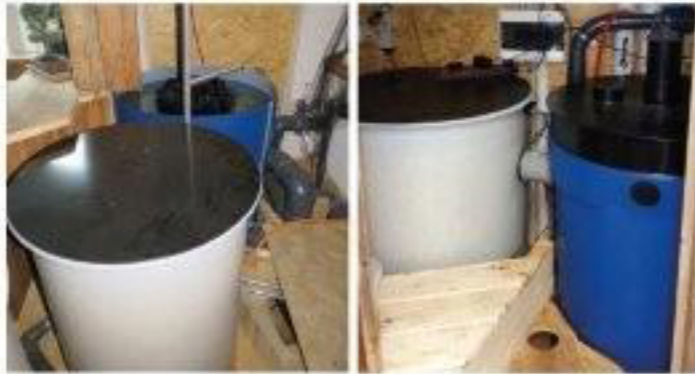
5000 Liter Biofilter im Wirbelbettverfahren
